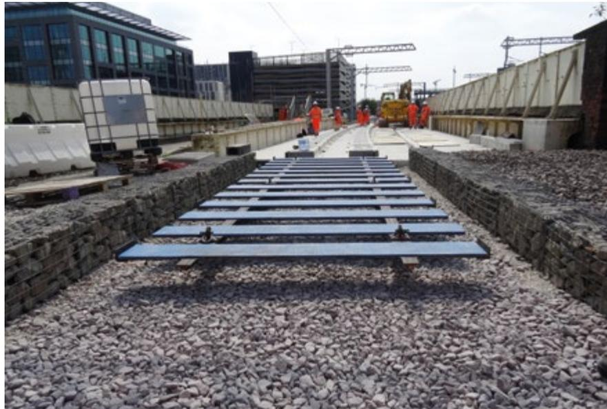
Die größte Herausforderung in der Bauphase waren die Kernbohrungen der hochbewehrten Fahrbahnplatte. Sind die IVES-Elemente einmal positioniert, werden sie nivelliert und mit einem hochfesten, schnell härtenden Vergussmörtel vergossen, wodurch Freiräume zwischen den Schienenbefestigungen und den Tragelementen ausgefüllt werden. Durch Sichtfenster aus Plexiglas kann sichergestellt werden, dass ein erfolgreicher Vergussvorgang mit fehlerfreier Oberflächenqualität erreicht worden ist.
