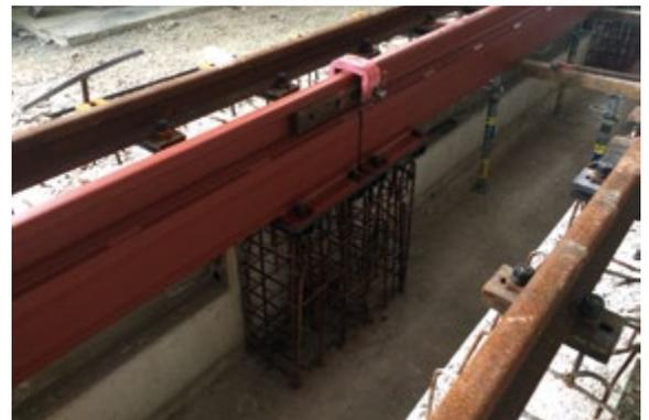
**Im Sommer letzten Jahres erhielt die Bahnbau Wels (BBW) den Auftrag der ÖSWAG Werft Linz AG Nfg. GmbH & Co KG (kurz ÖSWAG) zur Errichtung der Gleisanlage 3dSC. Kein alltäglicher Auftrag, zumal für den Kunden im Hallenbereich umspurbare Gleisanlagen zu realisieren waren.**
