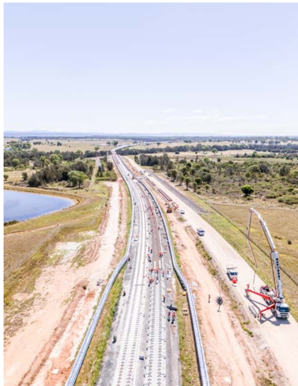
↳ Projekt Western Sydney Airport Line Auftrag: 44 Kilometer Feste Fahrbahn
