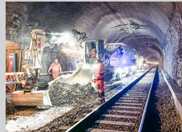
↳ Projekt Lötschberg- Scheiteltunnel Ort: Berner Oberland – Wallis, Schweiz Kunde: BLS AG Auftrag: Umbau von 1,5 km Doppel- gleis mit vier Weichen von Schotter- bauweise auf Feste Fahrbahn Bauphase: April bis Juni 2024
